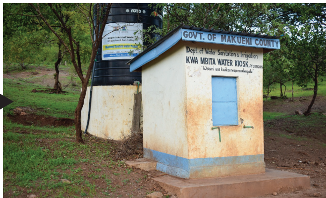
Muatineni Borehole Kiosk
