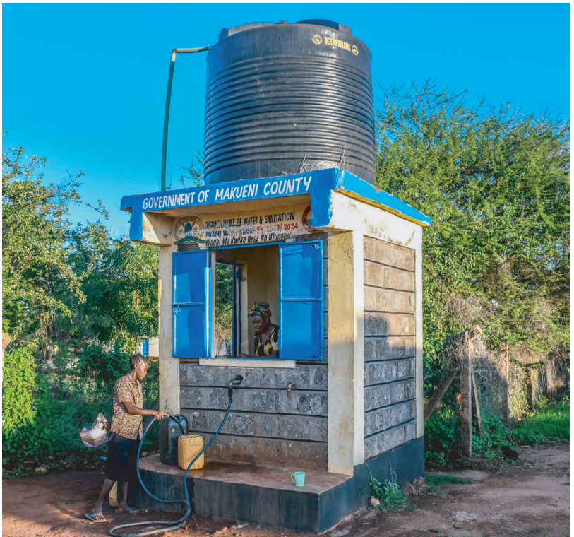
Miami Water Kiosk
