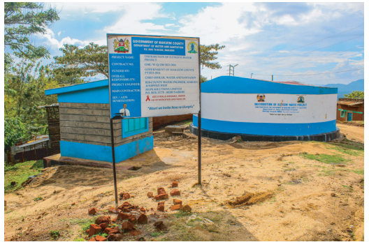
Ilengeni Water Project ▶
