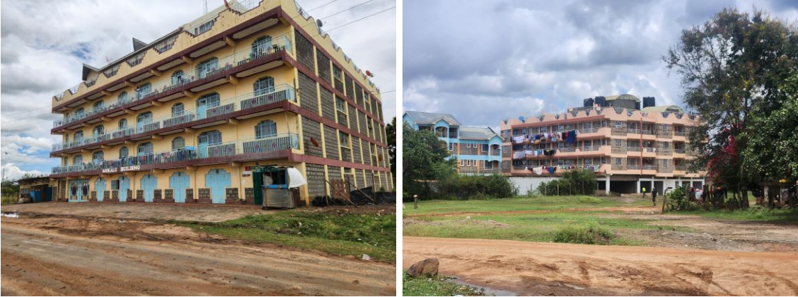
High rise (flats)
